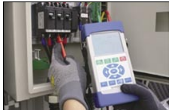
太陽光パネルの不具合をS☀️KODESを使えば地上の接続箱から検査可能です
