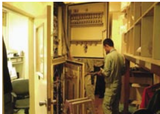
北九州市スマートシティ実証実験の電気工事風景
